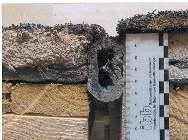
Bild 15 Ansicht von oben auf die Fuge 3 nach Beendigung des Brandversuches. Es ist zu erkennen, dass der Großteil der trockenen Systemfuge noch vollständig intakt ist und das Aufpilzen nur oberflächlich stattgefunden hat. An dem verbauten Holz können augenscheinlich keine Brandschäden festgestellt werden.
